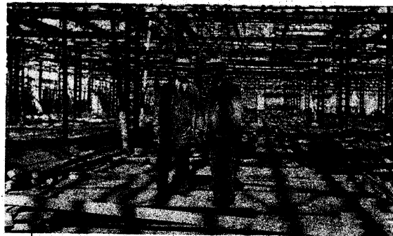
1937年ごろ、建設中の挙母工場（現在の愛知県豊田市）を視察する豊田喜一郎（右）とトヨタ自動車提供
