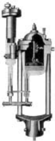
写真 1 Foxboro 社の水銀フロート式メータ (5)
