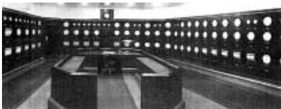
写真4 1940年代の精油所の制御室 9)
