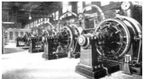
写真3 動力室に設置された蒸気エンジンの発電機
