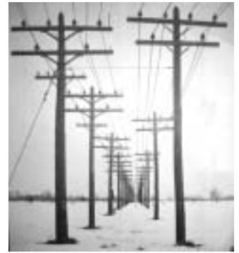
第3図 長距離送電線10,000ボルト (スミソニアン・アメリカ歴史博物館展示)
